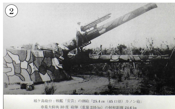
城ヶ島砲台：戦艦「安芸」の副砲「25.4 cm (45口径) カノン砲」 ※最大仰角 30 度 砲弾 (重量 235 kg) の射程距離 24.6 km
